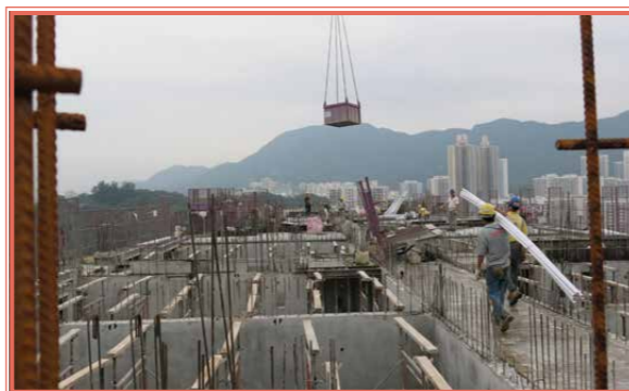
Proactive Construction Management System 基於位置實時現場安全管理系統
